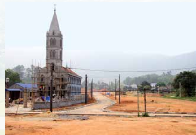
Nhà thờ đang được xây dựng tại khu Tái định cư Đồng Bông
